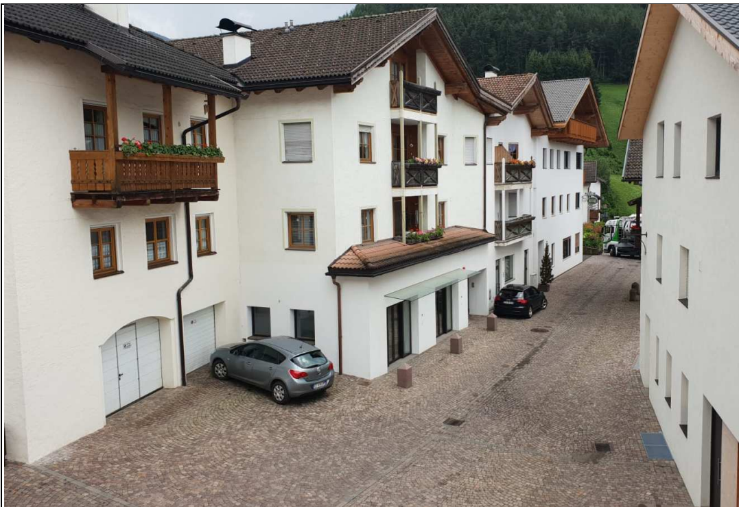
Gebäude des ehemaligen Gasthofes „Unterwirt“ im Ortszentrum von Lüssen.
